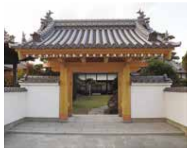
完成した真如山金剛禅寺山門
